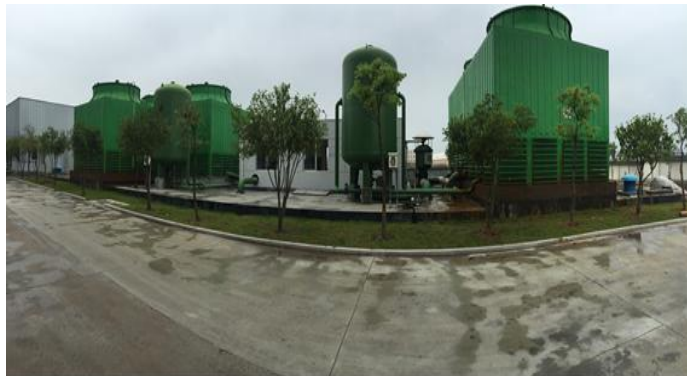
公司循环水站
